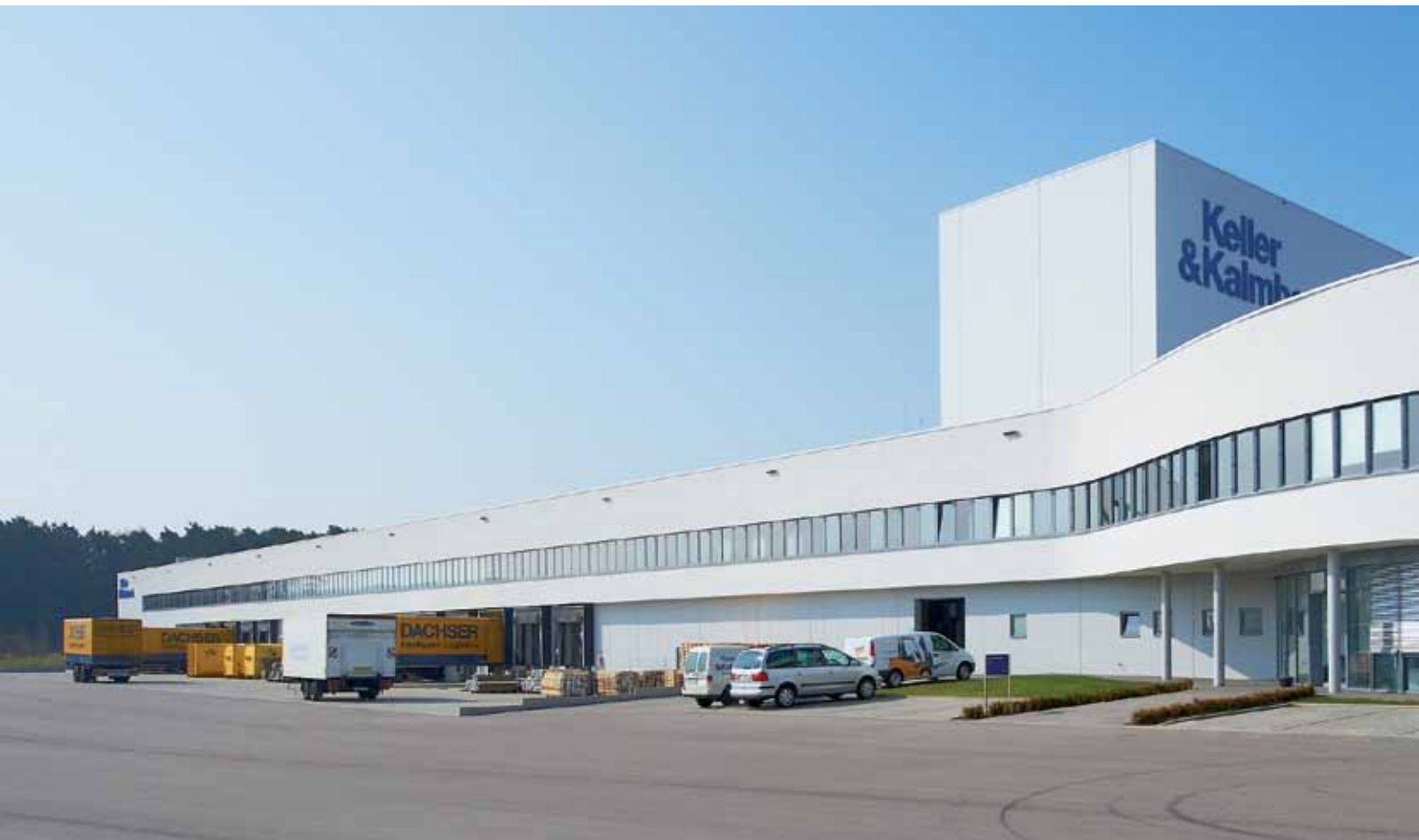
Здание Keller & Kalmbach GmbH (г. Хильпольшттайн) с продукцией компании Hörmann
